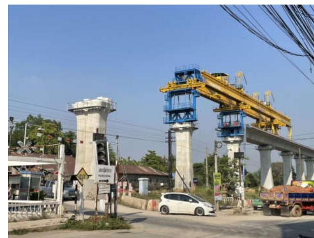
รูปที่ 1 งานก่อสร้างทางยกระดับทางรถไฟข้ามถนน ชุมชนศาลเจ้าสูงเนิน
